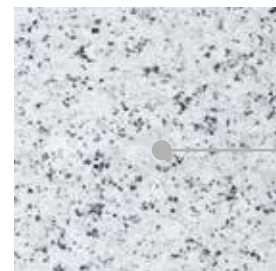
Cubierta de granito
